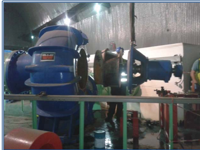
Mantenimiento de bomba de servicios generales
