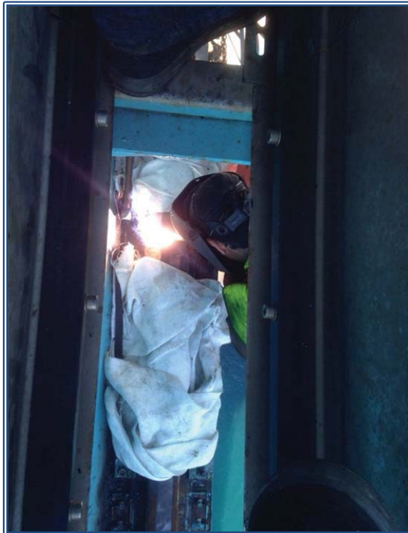
REFORMA DE FRENOS DE ELEVACIÓN
