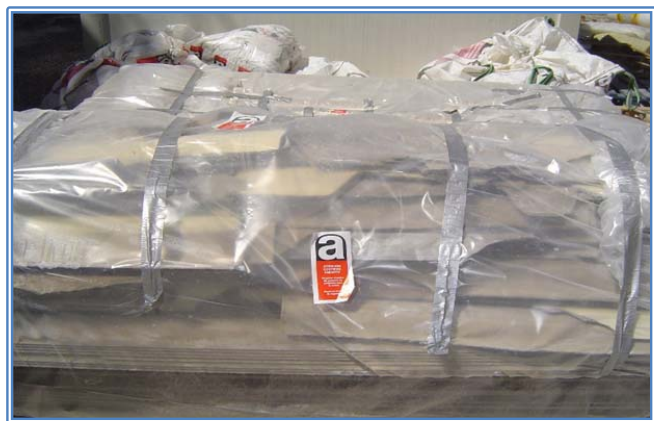
Retirada fibrocemento
