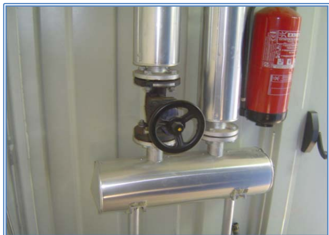
Aislamiento tuberías
